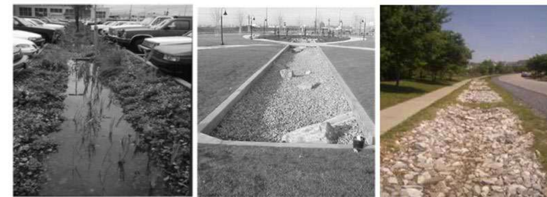
Tipologico di trincea d'infiltrazione
