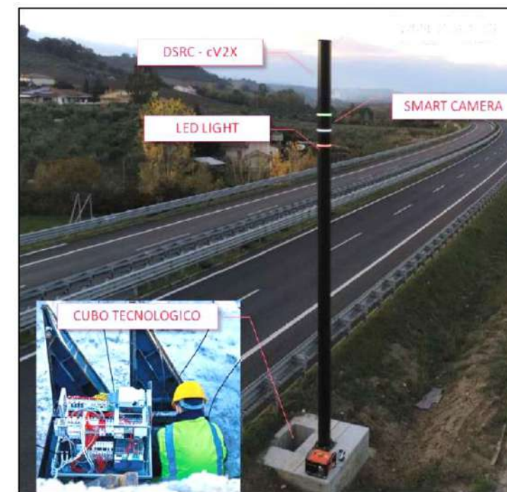
Postazione polifunzionale con cubo Tecnologico, per tratti all'aperto
