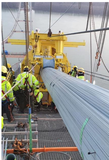
Figura 16: Compattazione dei cavi, Ponte sul Danubio a Braila
