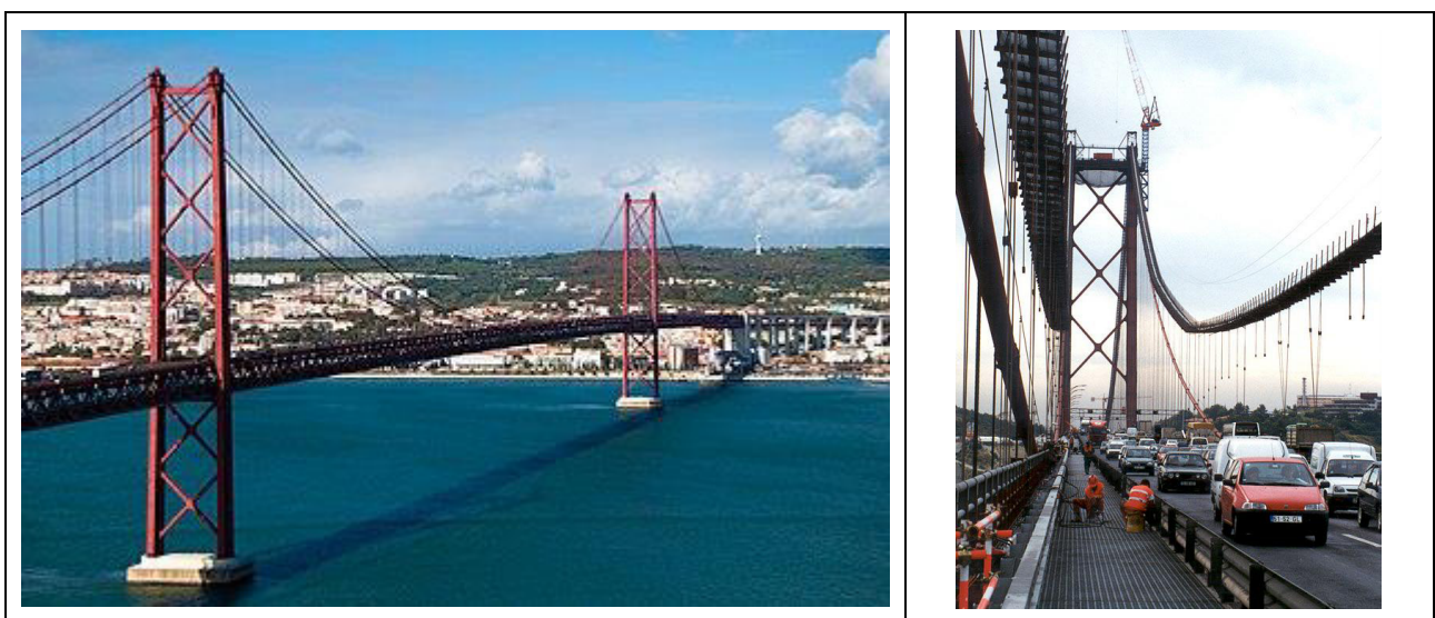
Figura 13: I doppi cavi sovrapposti del Ponte 25 de Abril
